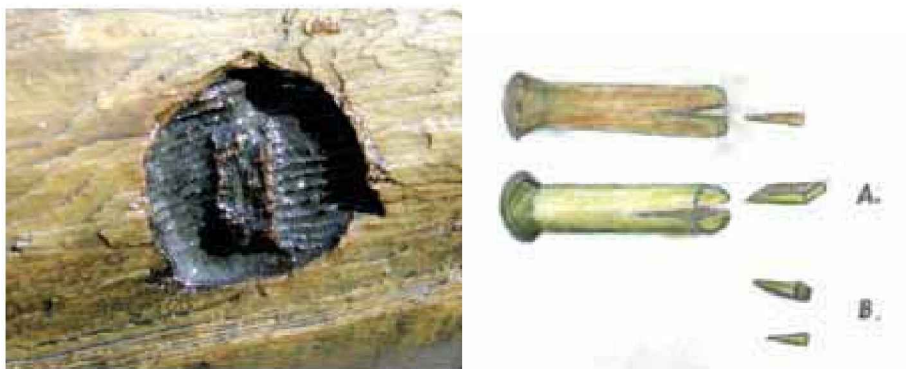
Bild 10a. Dymling med central kil genom ett av de dokumenterade spanten. Foto: Ulf Carneland. Bild 10b. Principskiss för kilning. Illustration: Harry Alopæus, Läns museet Gävleborg.
